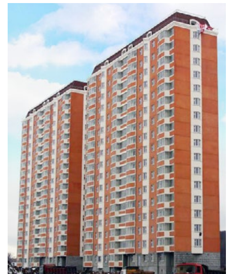
Новостройка в Серпухове
